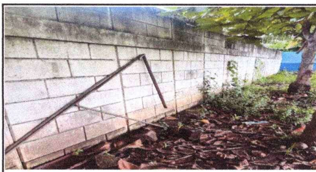
Foto 4: Sustitución de muro perimetral de block
