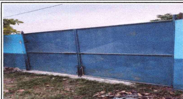
Foto1: Sustitución de portón de metal
