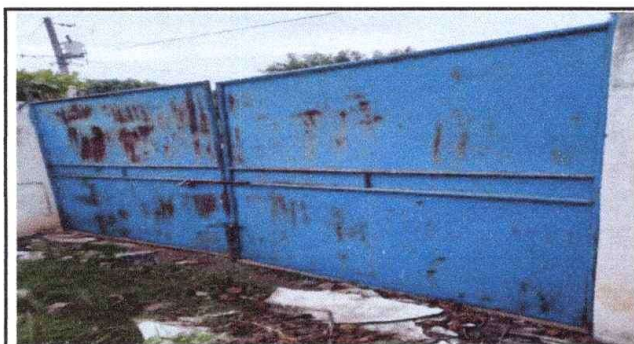
Foto 3: Sustitución de portón de metal
