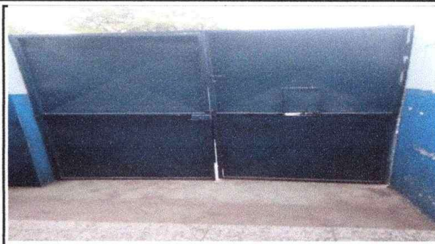
Foto2: Sustitución de portón de metal
