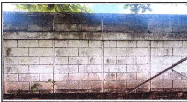
Foto 6: Sustitución de muro perimetral de block
