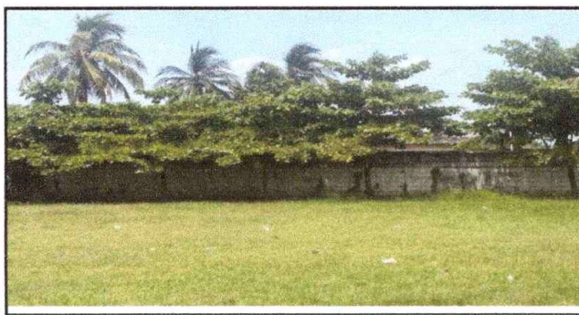
Foto 5: Sustitución de muro perimetral de block
